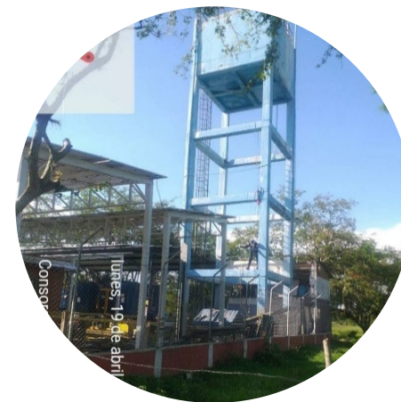
Reforzamiento de Tanques Elevados en El Hormiguero
