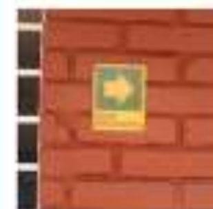
Demarcación y rutas de evacuación decoloradas, requieren renovación.
