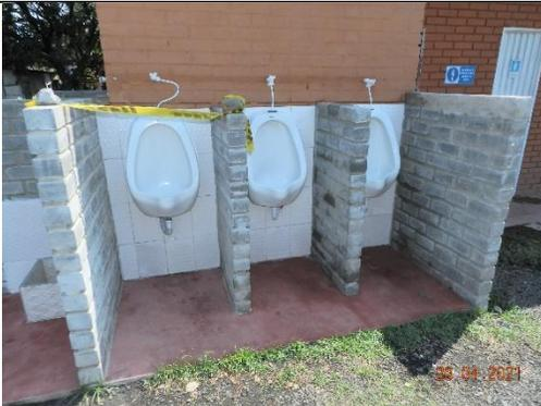
Mantenimiento baterías sanitarias Talleres del Distrito, construcción de baterías de orinales, enchapes de cerámica, muros divisorios en bloque de cemento. Instalación de redes de acueducto y de alcantarillado
