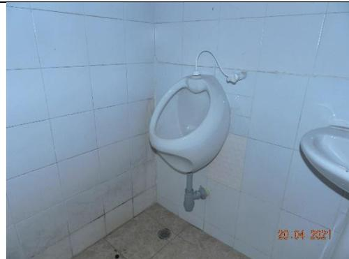
Mantenimiento baterías sanitarias Talleres del Distrito. Instalación de orinales, enchapes de cerámica
