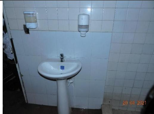
Mantenimiento baterías sanitarias Talleres del Distrito, instalación de lavamanos, instalación de dispensadores de gel antibacterial
