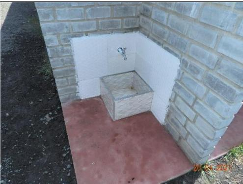
Mantenimiento baterías sanitarias Talleres del Distrito, construcción de lavatraapeador prefabricado, instalaciones hidráulicas y sanitarias
