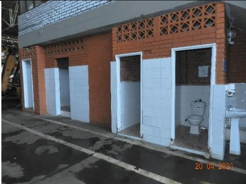
Mantenimiento baterías sanitarias Talleres del Distrito, instalación de aparatos sanitarios, enchapes de cerámica
