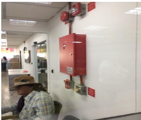
Foto: Sistema automático detección de incendio
