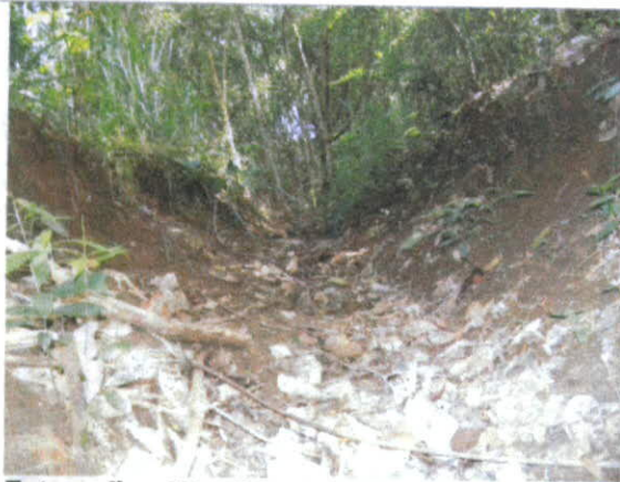
Fotografía 27. Estado actual cauce seco Zanjón del Burro.
