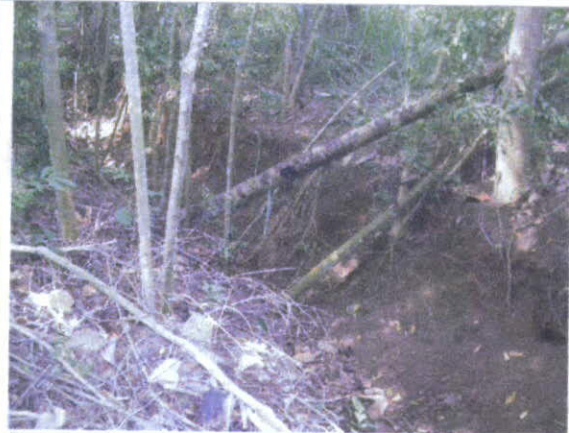
Fotografía 28. Estado actual cauce seco Zanjón del Burro.
