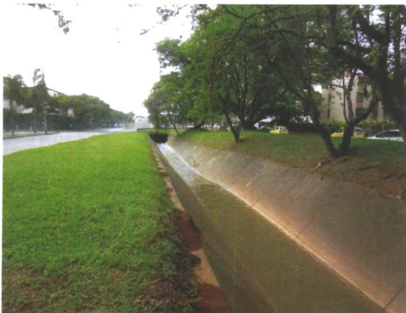
**Fotografía 3-3** Vista del canal Cañaveralejo hacia aguas abajo desde la calle 9, se observa la presencia de hormigueros que pueden ayudar al daño de las losas
