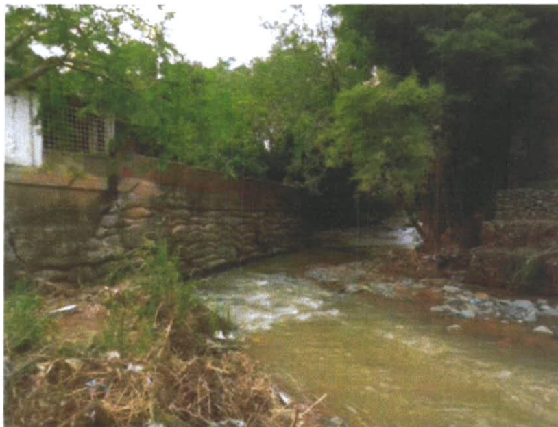
Fotografía 3-2 Vista del río Aguacatal hacia aguas abajo, se observan numerosas obras de control de erosión marginal en sus orillas
