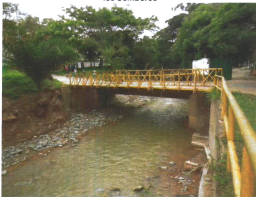
Fotografía 3-4 Vista del río Aguacatal hacia aguas arriba en el puente de los bomberos
