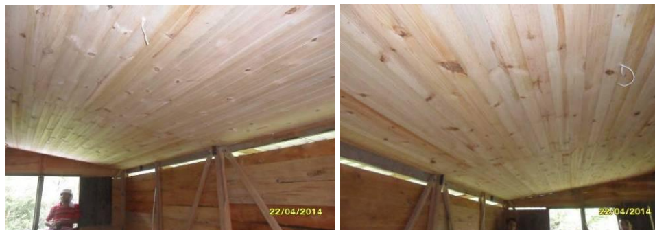
Techo del centro de visitantes de El Danubio con mantenimiento.
