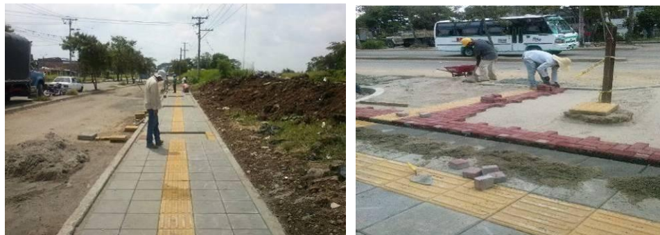
Humedal Isaías Duarte Cancino intervenido por mejoramiento de sendero, señalética y espejo de agua.
