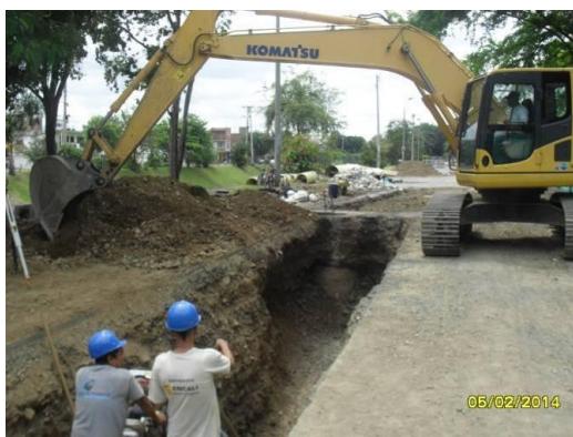
Colector en la Calle 73 (avenida ciudad de Cali) con Diagonal 26G5 a 26G7
