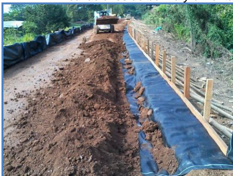
Construcción de dique en MSR
