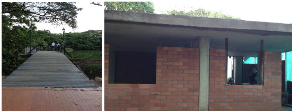
Mejoramiento de infraestructura en el Ecoparque Lago de las Garzas
