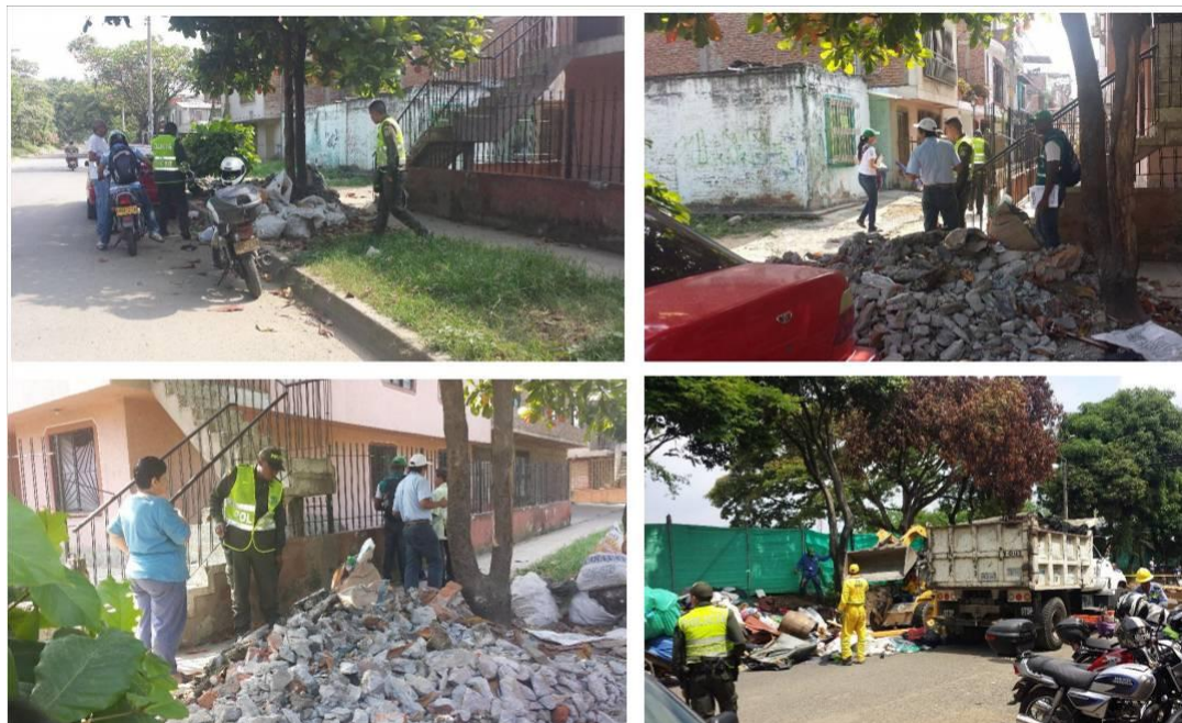
Acciones de vigilancia y control al arrojo caldestino de escombros.
