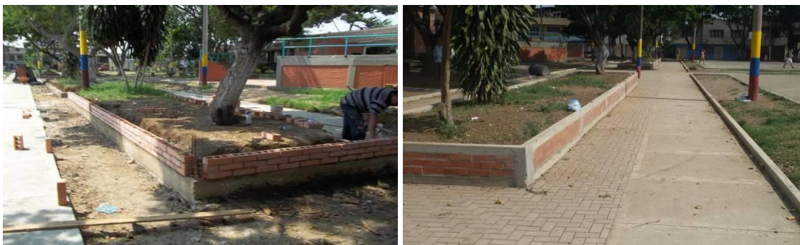
Parque barrio Guaduales, carrera 6n entre calles 71h y 71j. Durante (izq) y Después (der)
