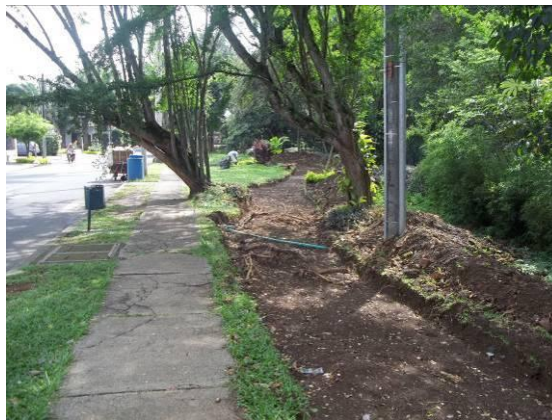
Corredor comuna 22 durante su construcción.
