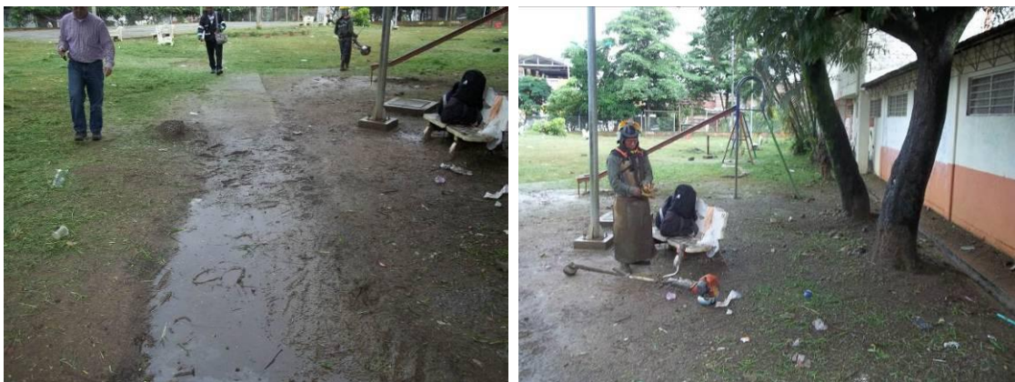
Parque Lourdes cra 73d con calle 1b. Durante la fase de preparación y adecuación.
