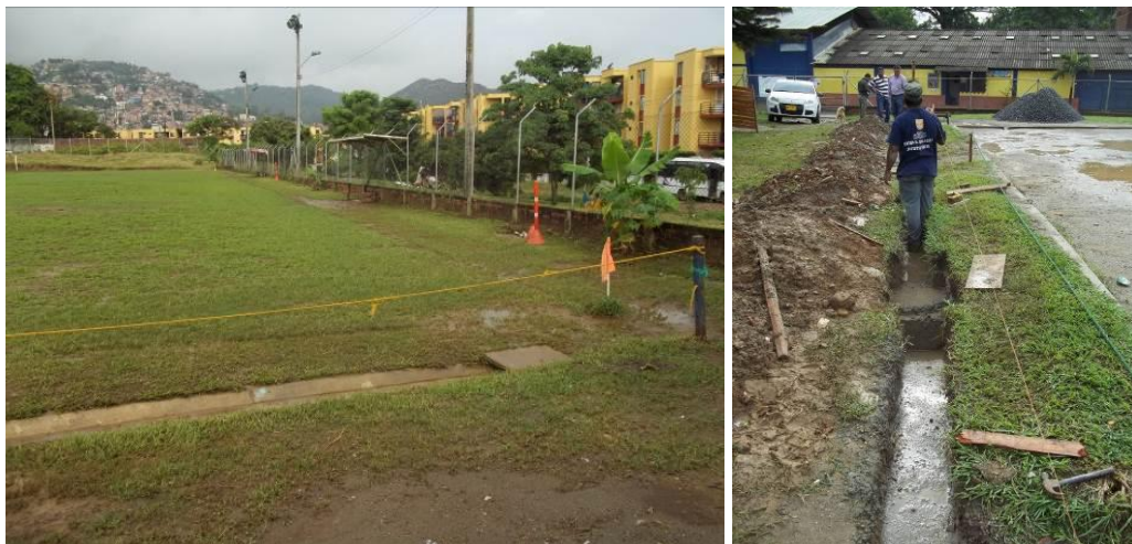
Parque barrio colinas del sur Traversal 2abis con cra 74bis. Antes (izq) y Durante (der)
