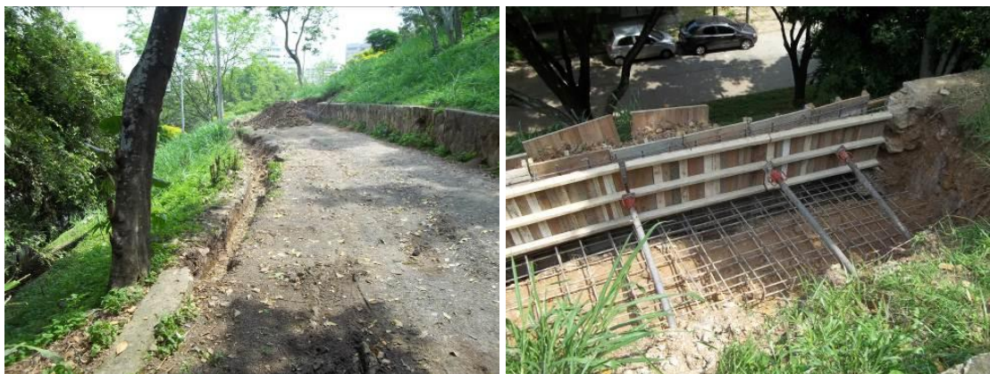
Parque las caracolas barrio santa monica, avenida 10n con calle 24n. Después.
