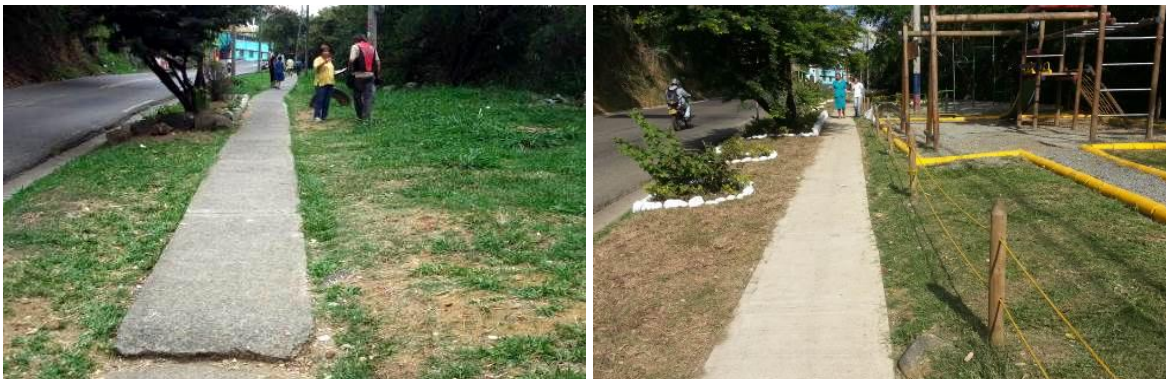
Barrio Villa del Mar, avenida 4 oeste con calle 26 oeste. Antes (izq) y Después (der)
