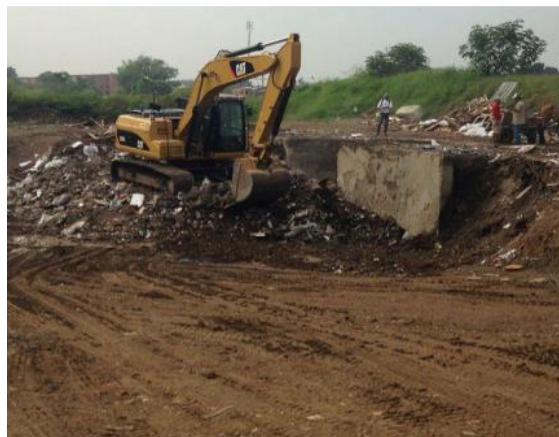
Descolmatacion de EPD Cra 50.
