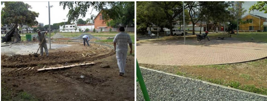
Parque Barrio El Refugio, calle 3 con cra. 67. Durante (izq) y Después (der)
