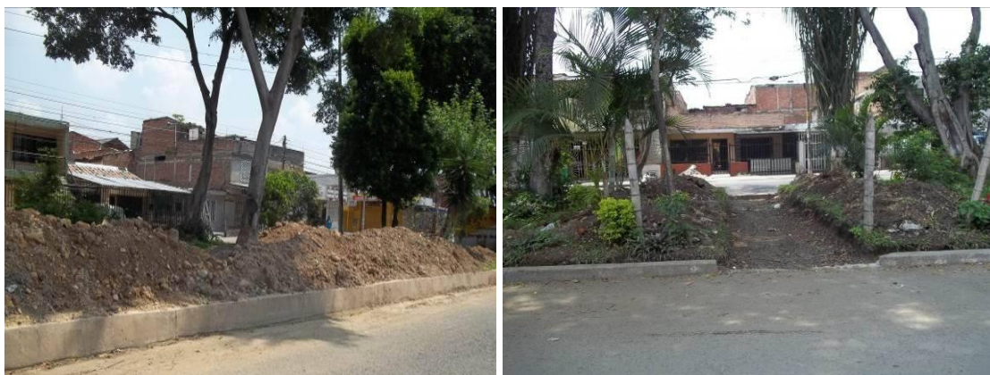
Recuperación ambiental y paisajística separador vial barrio union de vivienda popular; dirección: carrera 41b entre calles 40 y 48. Durante/se construcción.
