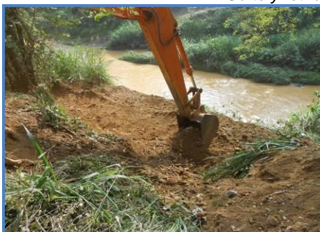
Excavaciones de berma y cimentación, y relleno para cimentación del dique
