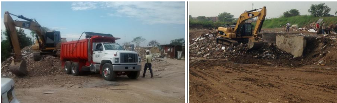
Estacion de transferencia Carrera 50.
