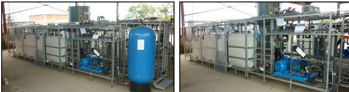
Planta de Tratamiento de lixiviados en operación.
