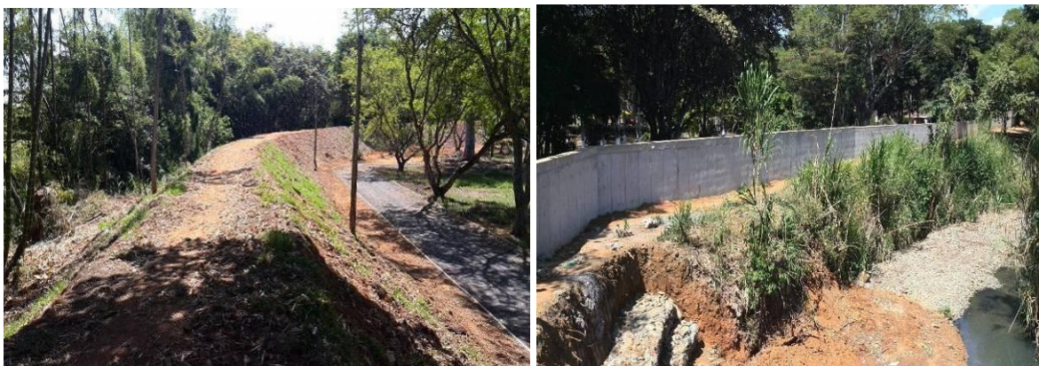
Dique en la parte sur del parque El Ingenio. Muro de contención para control de erosión en Calle 14
