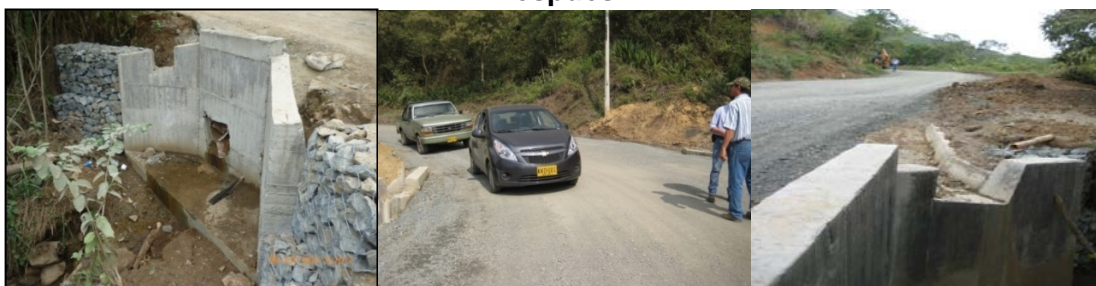
Construcción Muro de Contención - 24 ml, Alcantarilla y conformación Vial
