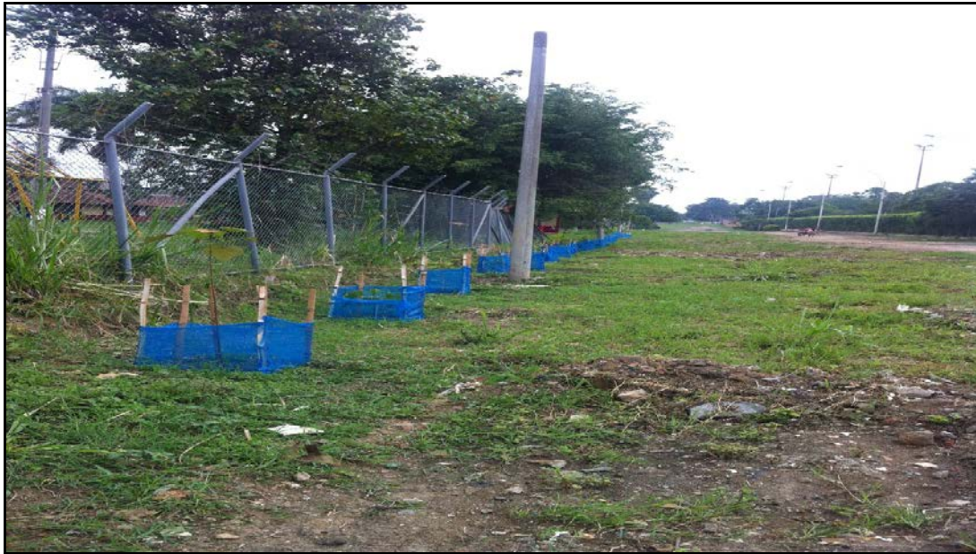
Recuperación de la vía con material vegetal.
