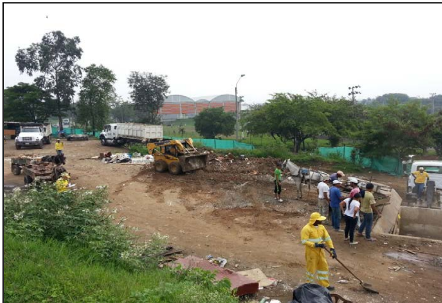
Operación de transferencia donde se observa los roll off en operación, recibiendo escombros de los carretilleros
