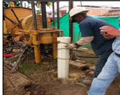
Figura 1. Perforación del Piezómetro y Entubado del Piezómetro.
