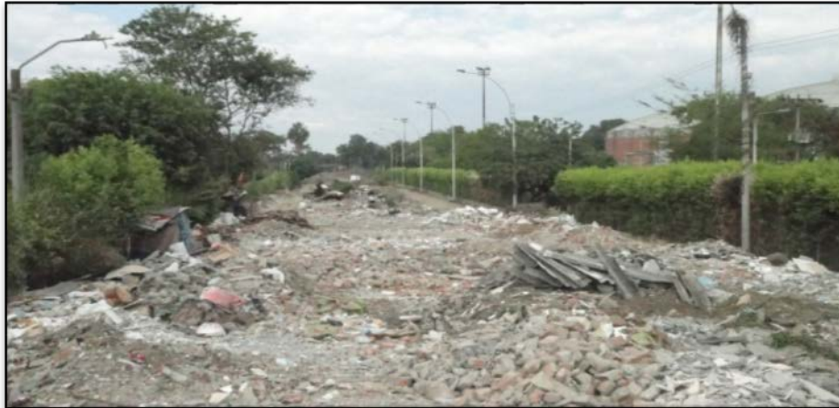
Vía de acceso a B/ Petecuy 1 totalmente colmatada por escombros
