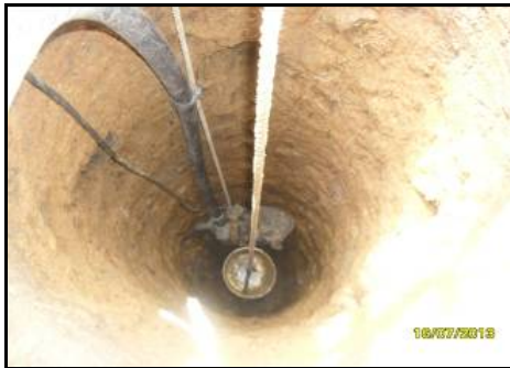
Figura 1. Perforación del Piezómetro y Entubado del Piezómetro.
