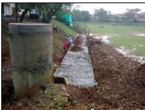
Construcción de colector Venezuela en la comuna 20
