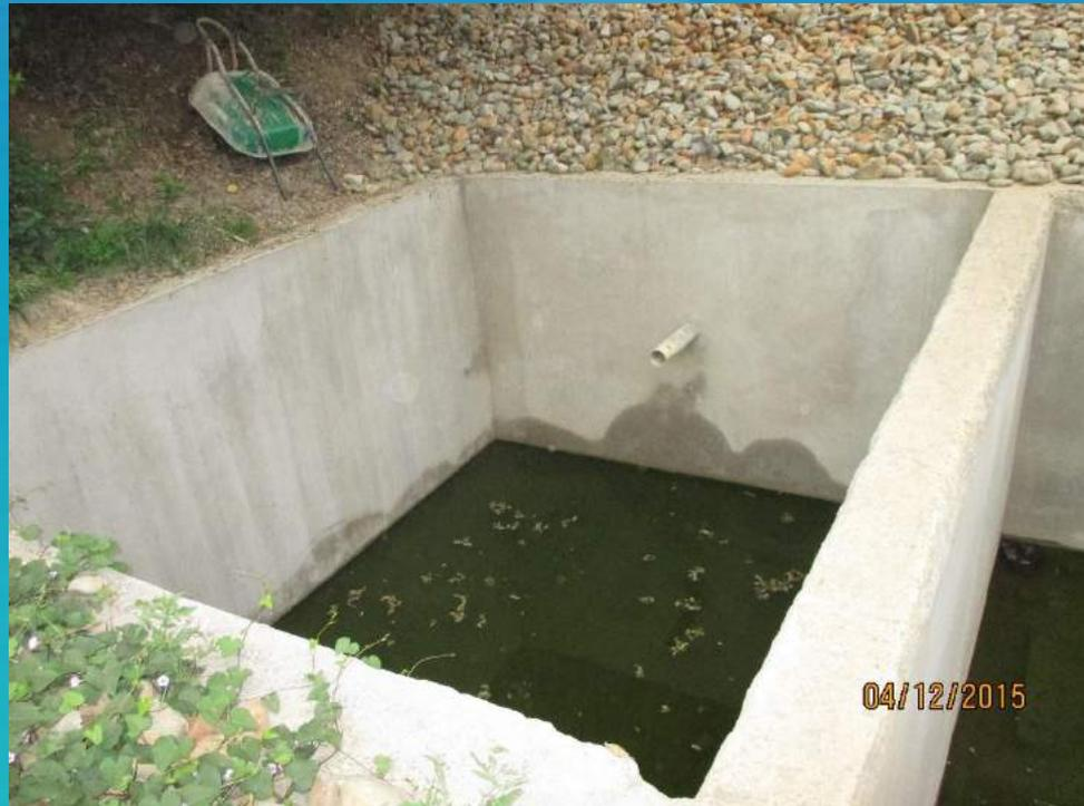
Filtros anaeróbicos con repello impermeabilizado.
