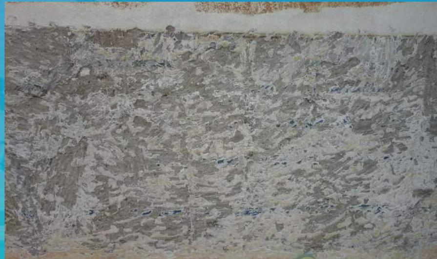
Alistado de muros para la aplicación del mortero impermeabilizado.
