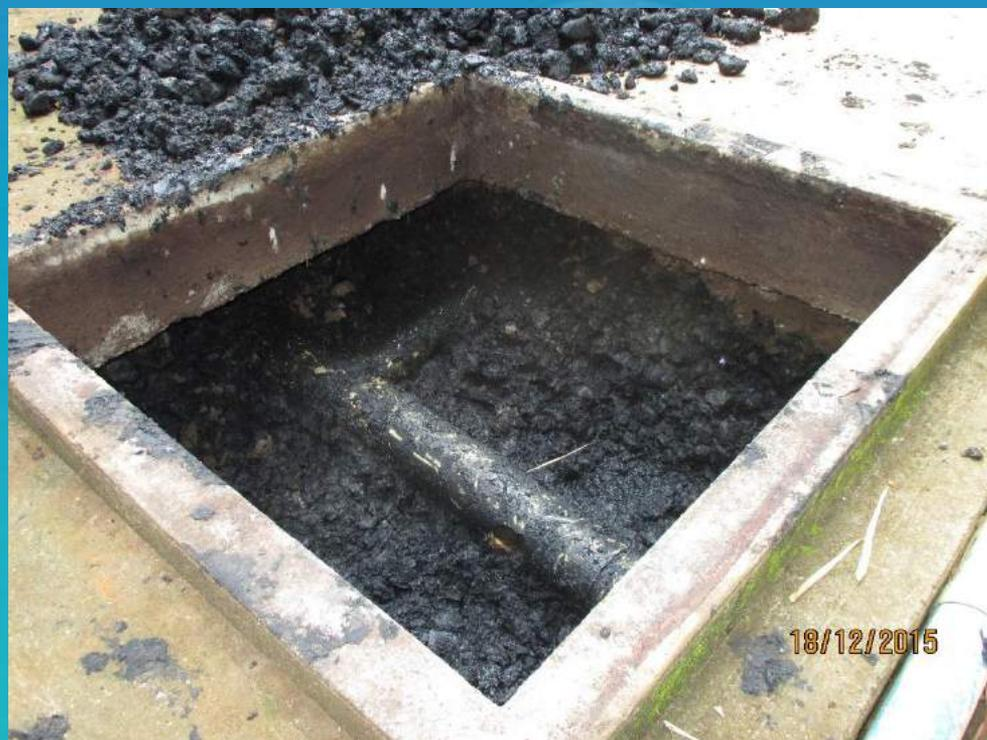
Retiro de canto rodado del filtro anaeróbico.
