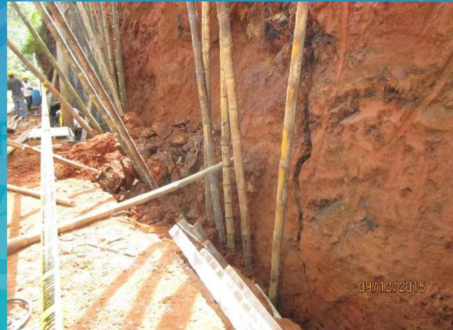
Primer derrumbe de excavación por filtración de cámara existente para muro de contención.
