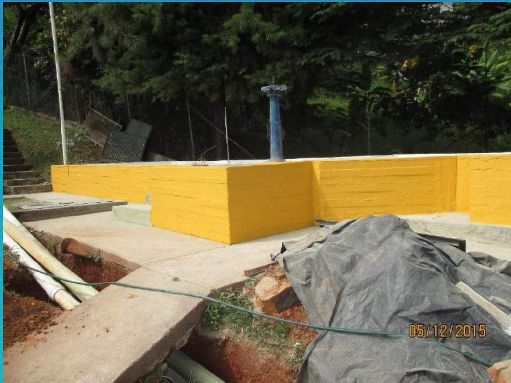
Pintura en muros exteriores de los filtros dinámicos.
