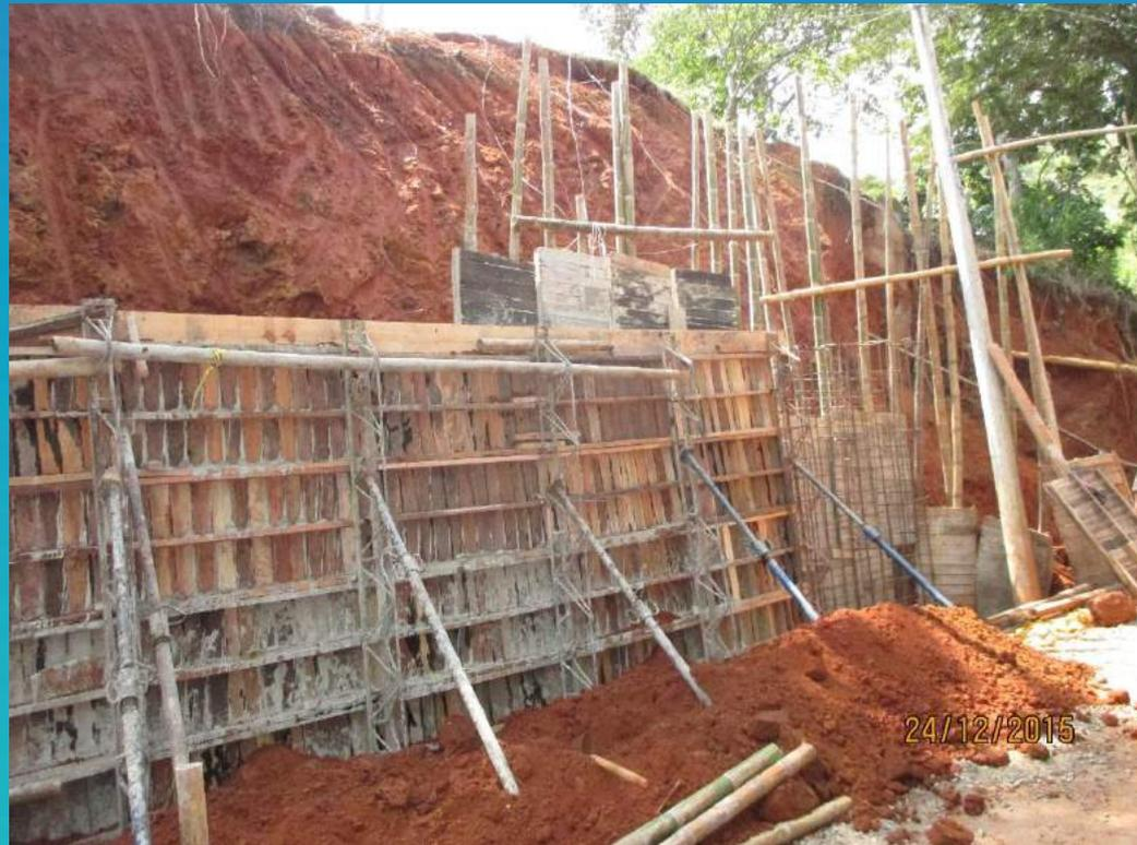
Fundición de muro de contención.
