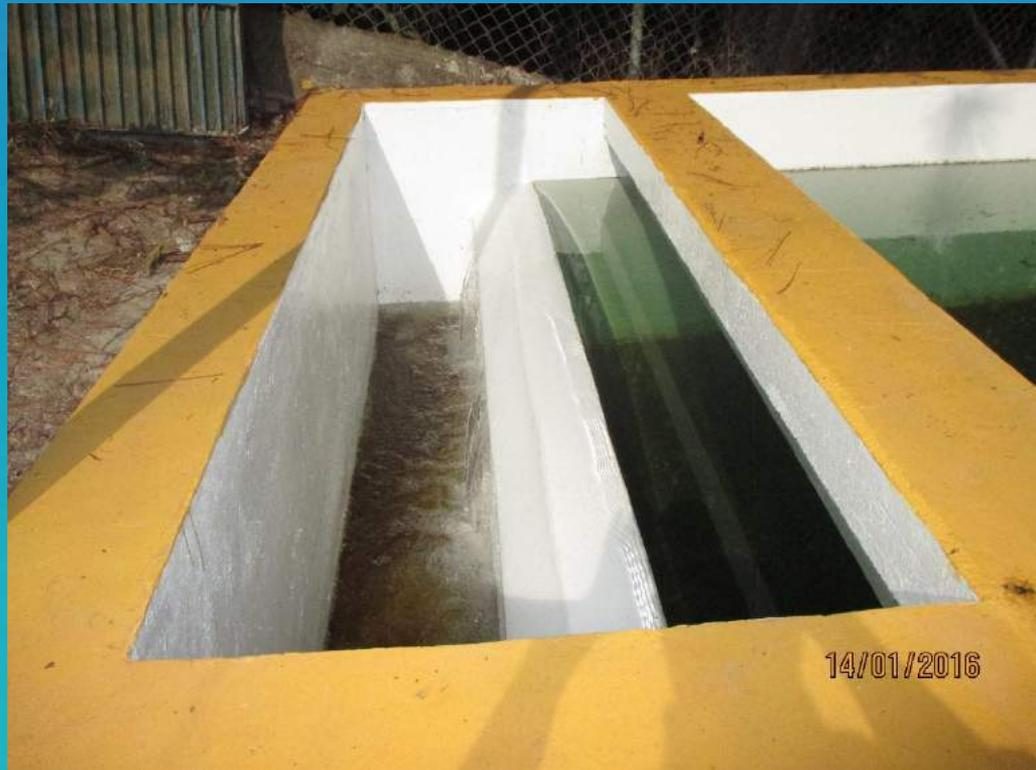
Canaleta de salida del desarenador terminado.
