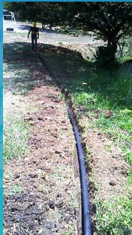
Instalación de tubería para agua de lavado.
