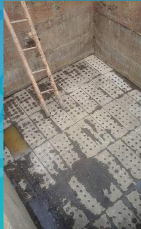
Retiro de canto rodado y lavado de los filtros anaeróbicos.
