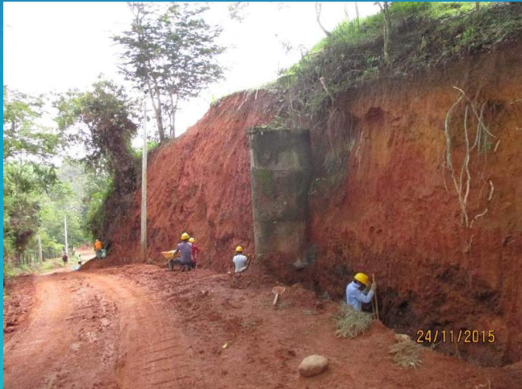
Excavación general para muro de contención.
