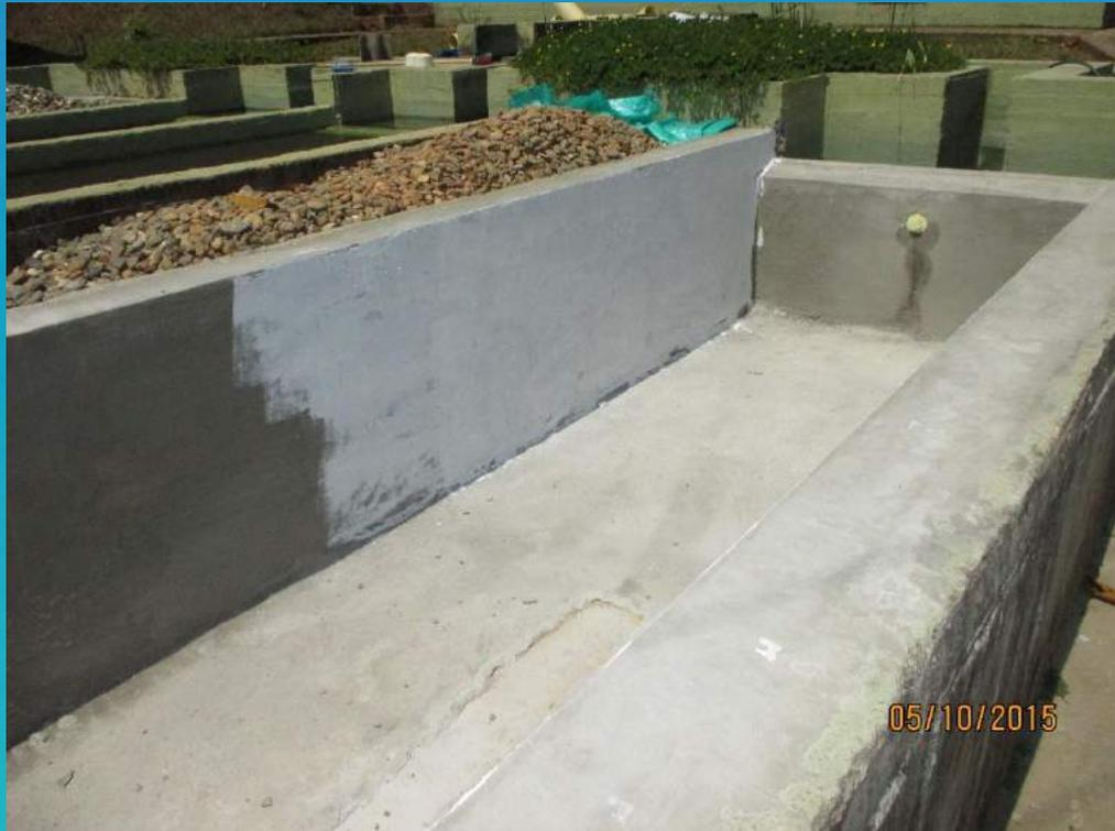
Filtro hidrodinámico repellado con mortero impermeabilizado.
