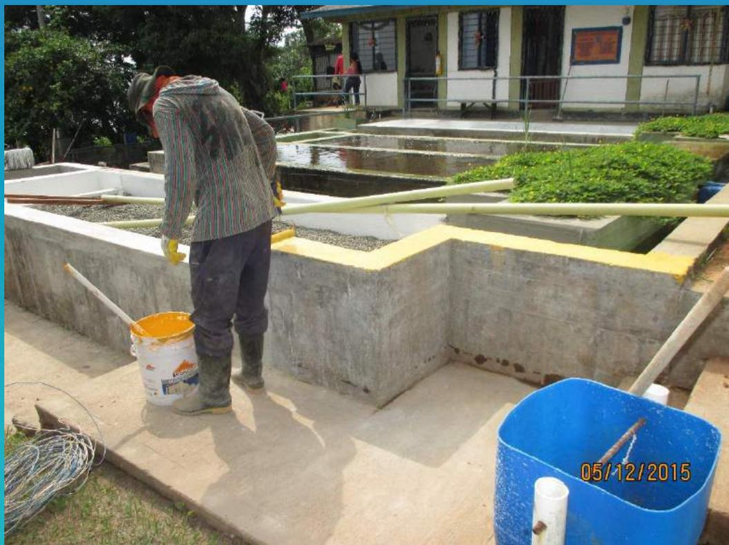
Alistado exterior de muros de filtros dinámicos para pintura.
