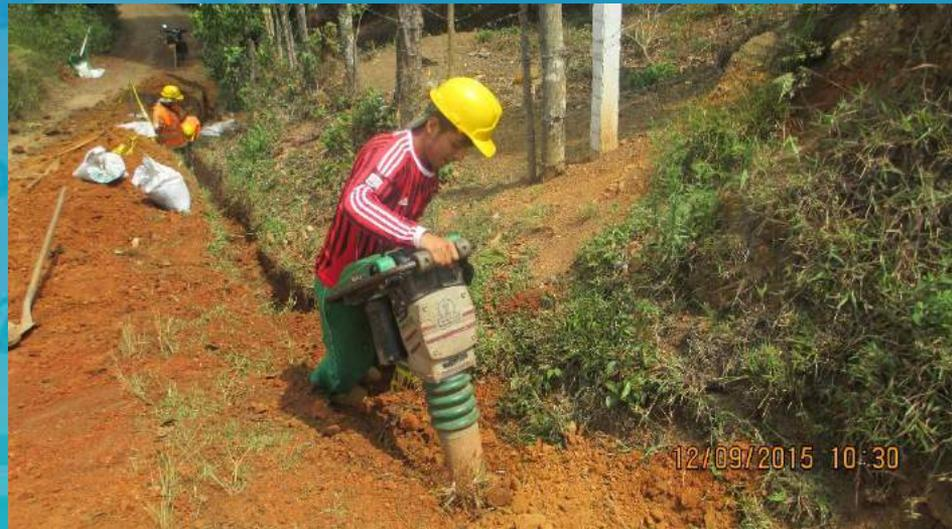
Relleno compactado con equipo neumático.
