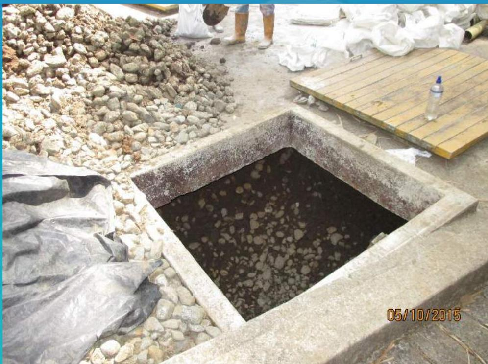
Retiro de canto rodado del filtro anaeróbico.
