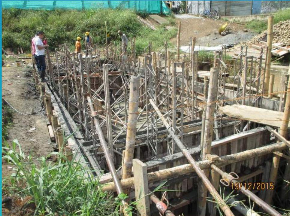
Fundición de muros de filtro fitopedológico.
