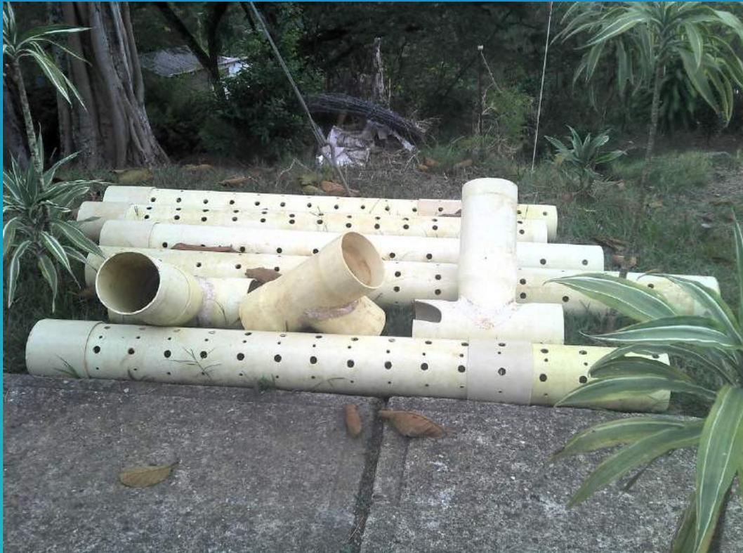
Retiro de tubería de filtros para reinstalar.
