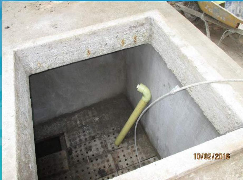
Colocación de mortero impermeabilizado para los filtros anaeróbicos.
