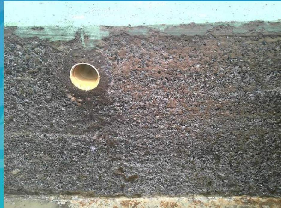
Alistamiento de muro para instalación de mortero impermeabilizado.
