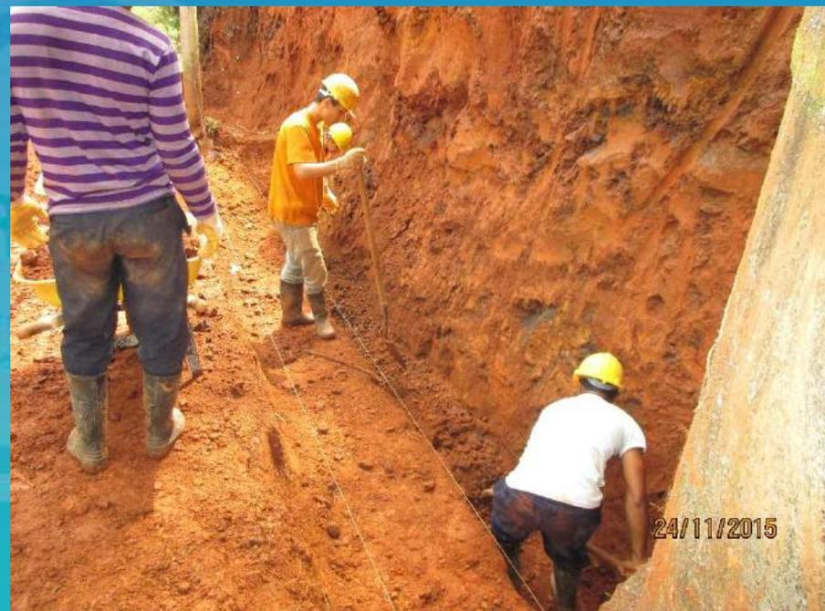
Excavación para construcción de muro de contención.
