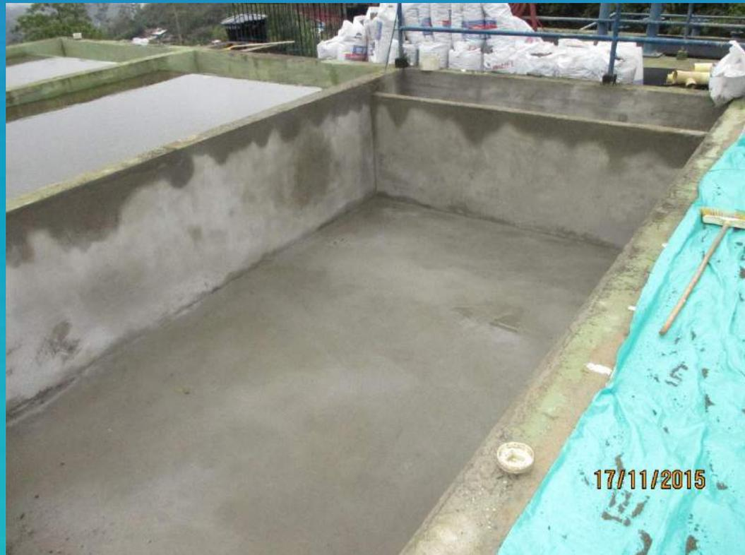
Mortero reparador y repello impermeabilizado en filtros gruesos.
