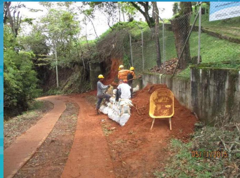
Excavación y acarreo para construcción de muro de contención.
