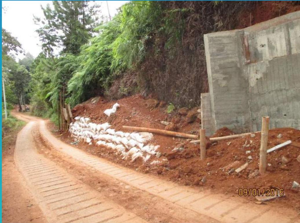
Material acarreado para el relleno posterior del muro de contencion.
