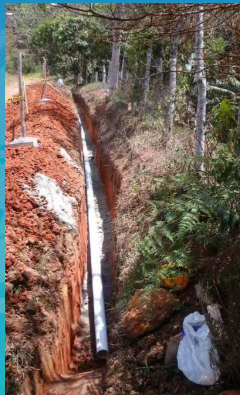
Instalación de tubería con su lecho de arena.
