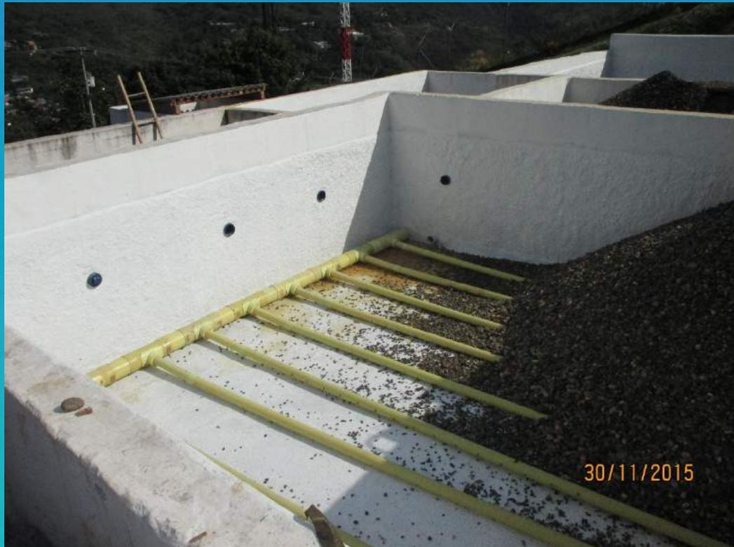
Reinstalación de tuberías filtros gruesos.
