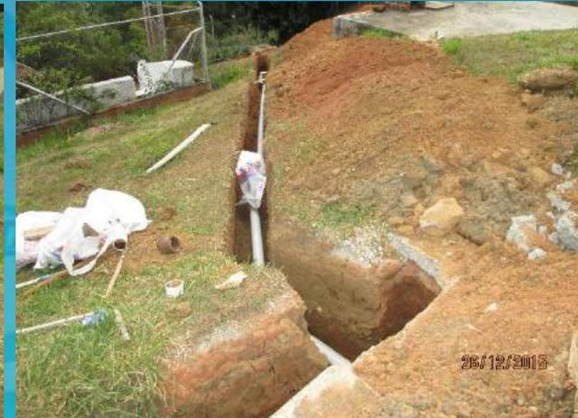
Instalación de tubería para by-pass.
