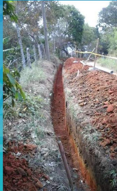
Labores de excavación para instalación de tubería.
