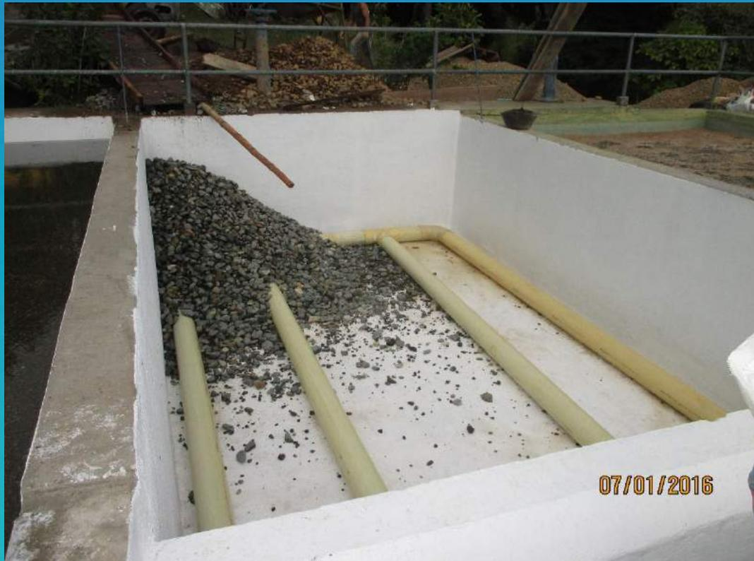
Reinstalación de tuberías filtros gruesos.
