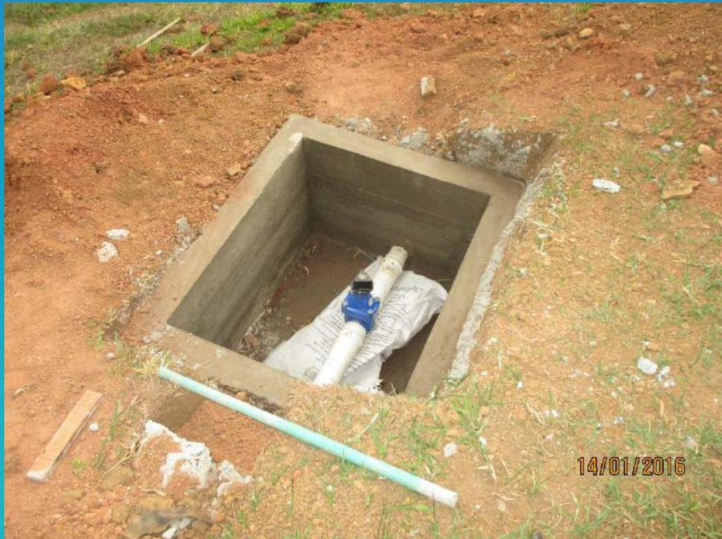
Instalación de válvula para by-pass.
