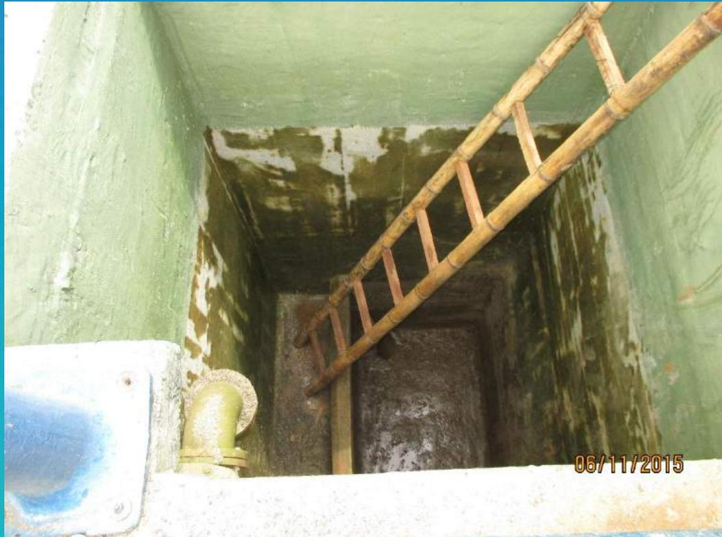
Vista filtro rápido después de retirado el material filtrante.
