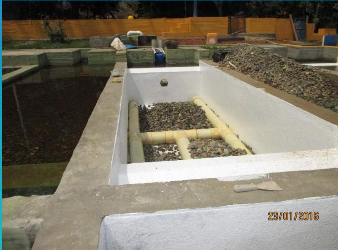
Reinstalación de tubería filtros dinámicos.
