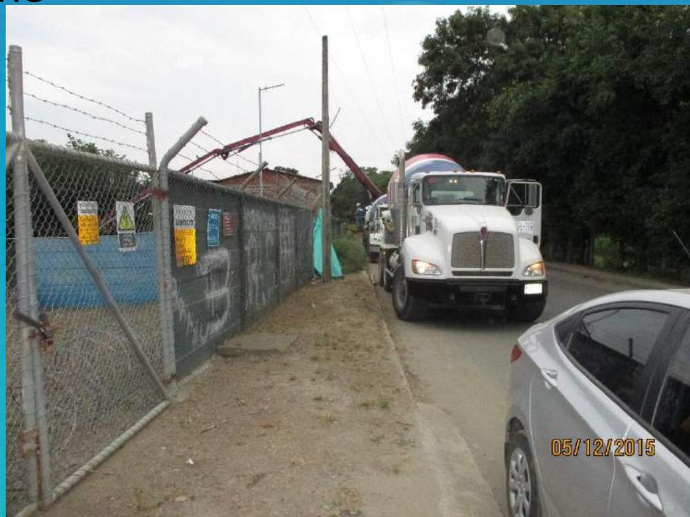
Vaciado de concreto premezclado para losa de fondo del filtro fitopedológico.
