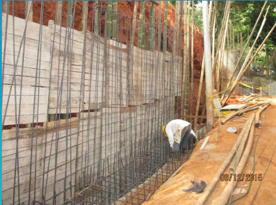
Armado de refuerzo para muro de contención.
