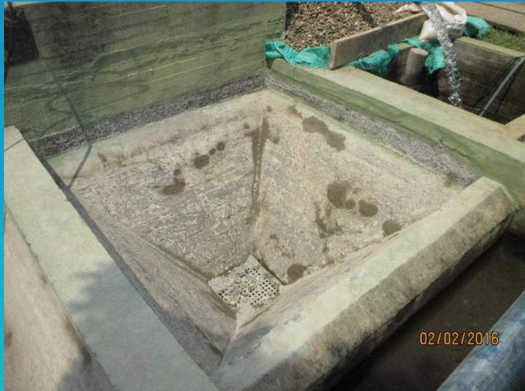
Alistamiento para mortero reparador y mortero impermeabilizado de floculadores.
