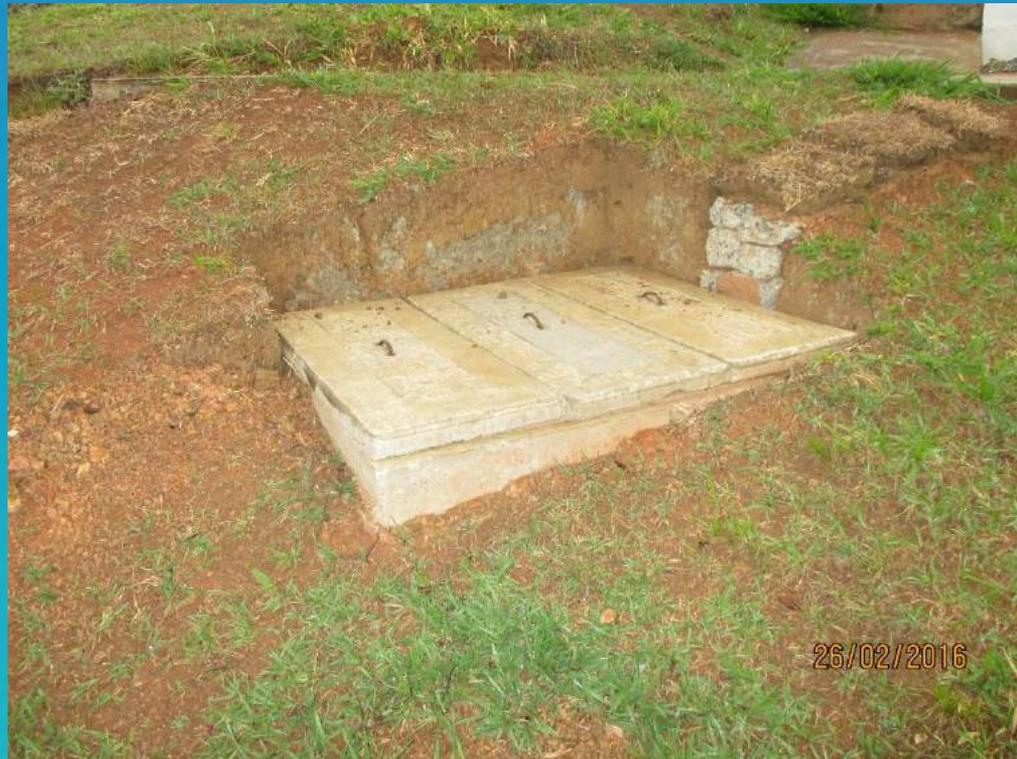
Construcción cámara para válvula de by-pass.
