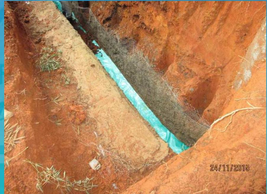
Estabilización de talud con mortero y malla gallinero para muro de contención.
