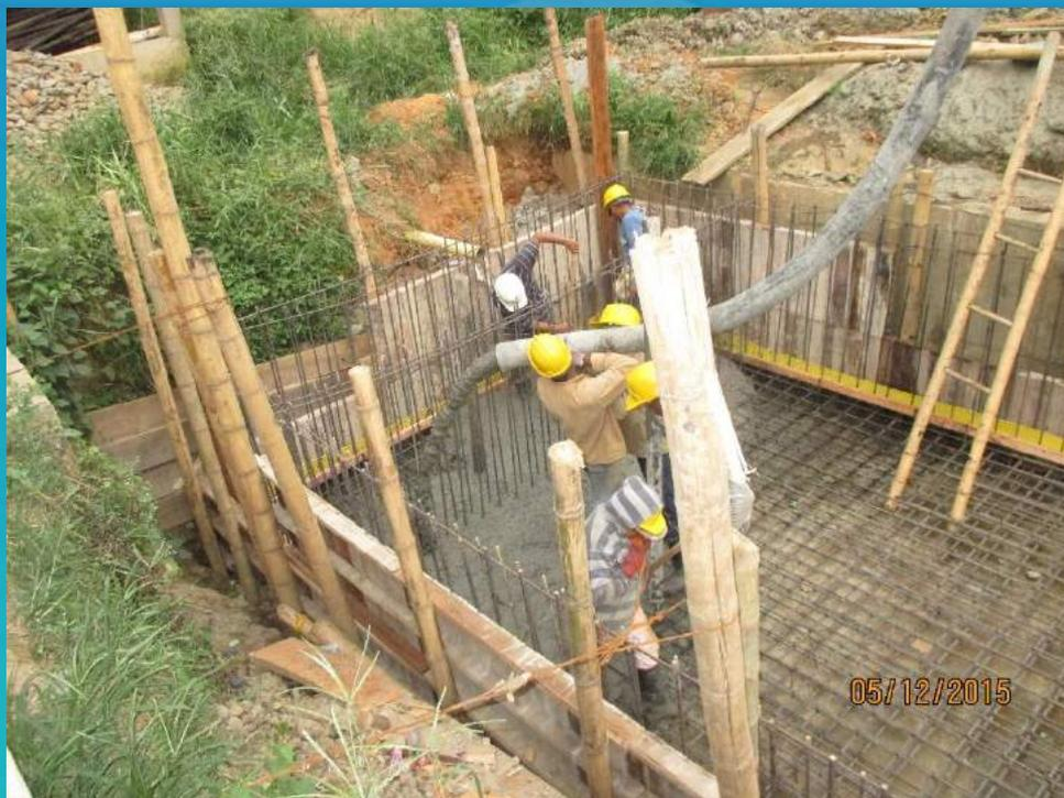
Fundición con concreto premezclado de losa de fondo del filtro fitopedológico.
