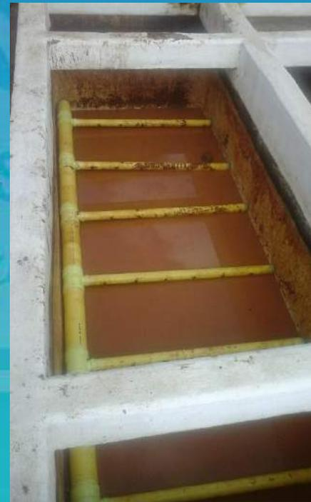
Retiro de material filtrante para lavado de filtros dinámicos.
