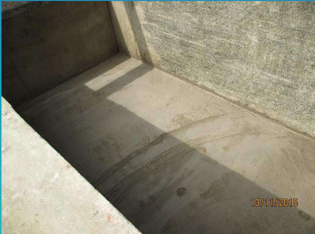
Mortero reparador y repello impermeabilizado en losa de fondo de desarenador.
