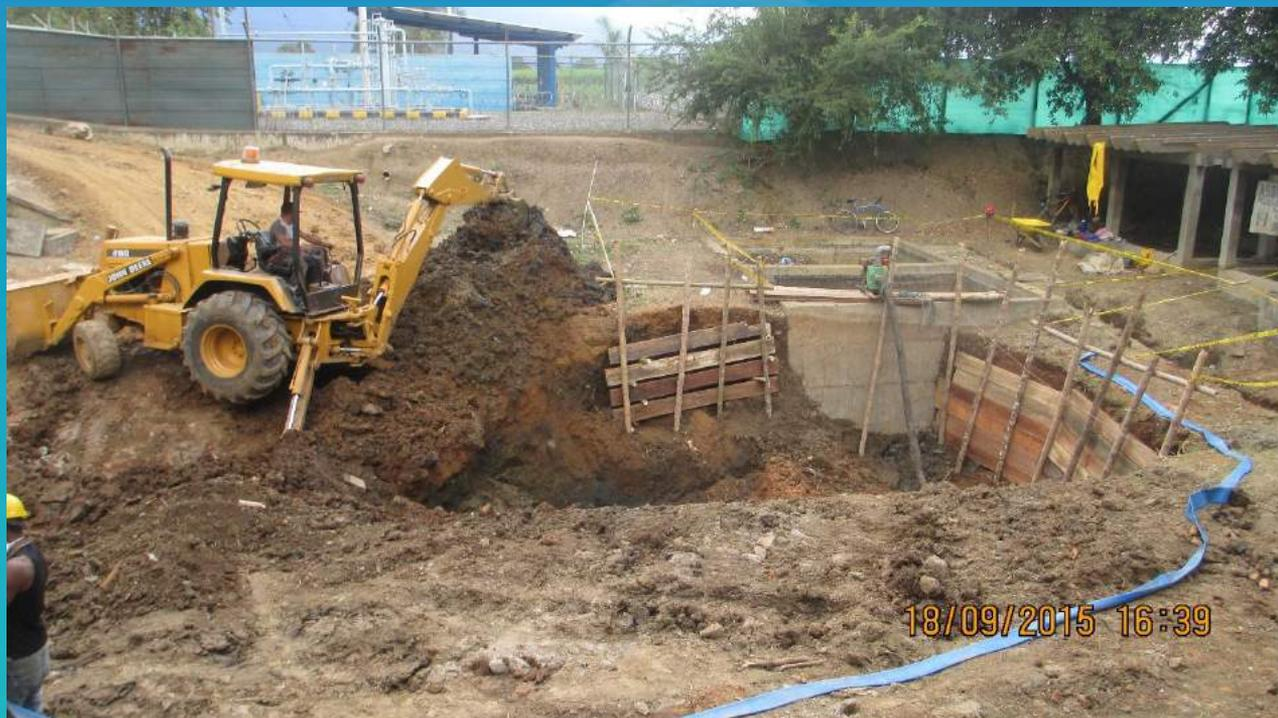
Excavación para la construcción del filtro fitopedológico.
